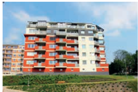
Realizováno: U CENTRÁLNÍHO PARKU II, bytový dům B13 Zlín
