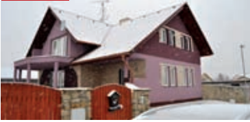
Novostavba rodinného domu Kunovice /okr. UH
