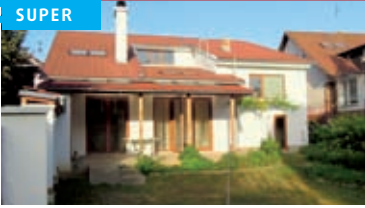
Novostavba rodinného domu se zahradou Zlín - Kostelec / okr. ZL N05821
