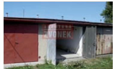
Garáž Valašské Meziříčí - ul. M. Alše
