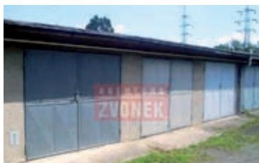
Garáž Valašské Meziříčí, ul. M. Alše
