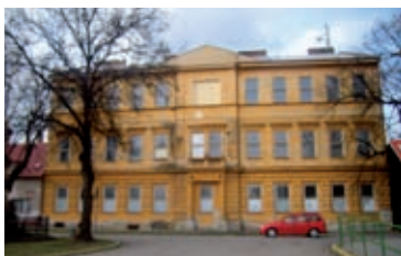
Komerční objekt Kvasice (okr. ZL)
