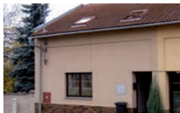
RD Míškovice (okr. KM)
