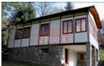
Chata Buchlovce - Smradávka Dřevěná chata 1+1 s kamennými základy. V chatě je suché WC, elektřina, voda ze studny. Vytápění na tuhá paliva. Pozemek 550 m 2 . ☎ 603 432 409 545.000 Kč
