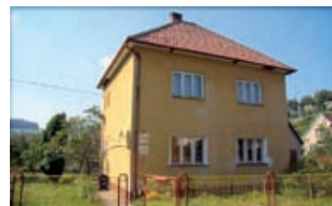
RD Brumov - Bylnice (okr. ZL)
