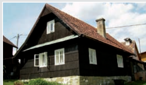
Huslenky (okr. VS) 1.120.000 Kč Dřevěnice s kamennou hospodářskou přístavbou
